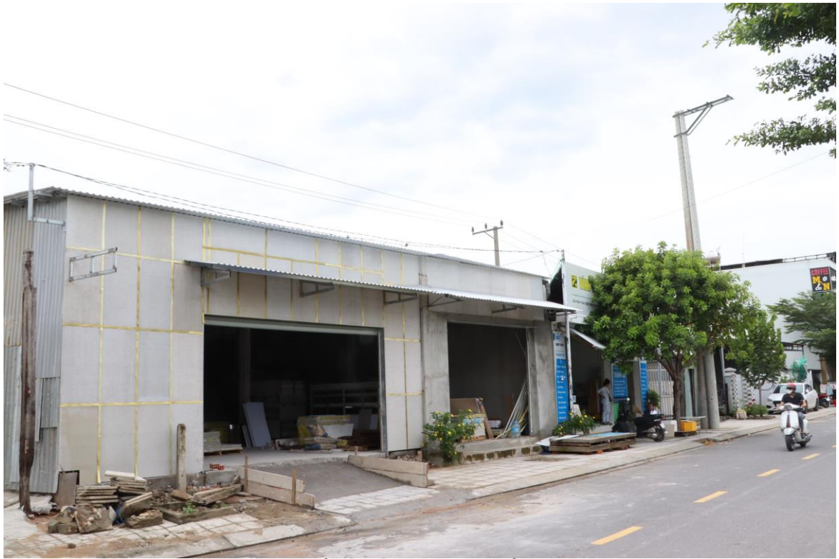
Lưới điện cũ đang vận hành và tuyến lưới điện mới đã lắp
